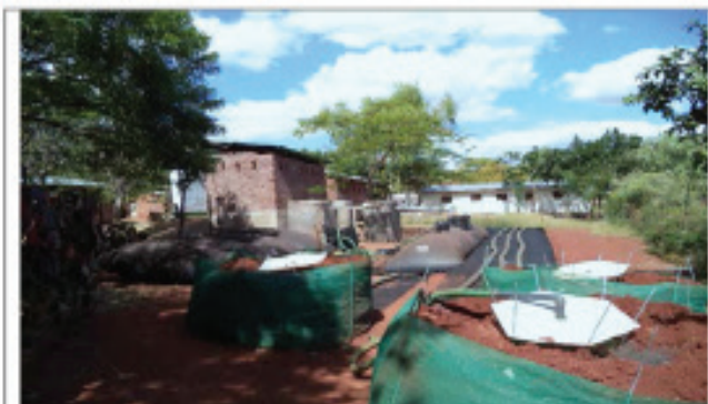
Figure 2 : Flexigester connected to pour flush toilet
